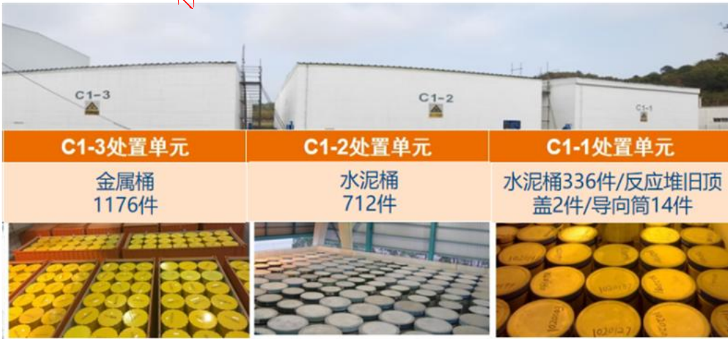
图 1 北龙处置场已接收废物包在处置单元存放示意图
